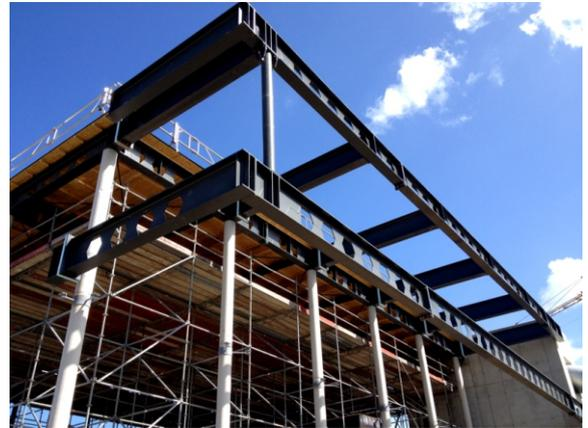
Auskragende Stahldachkonstruktion angeschlossen mit ISO-Körben
