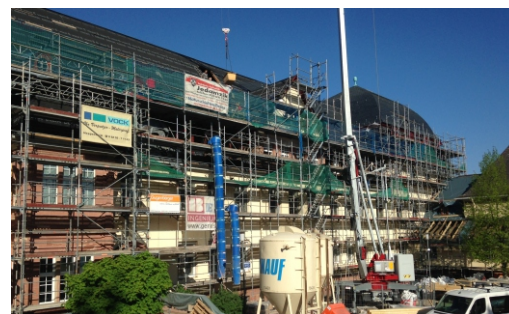
Bestandsgebäude während der Baumaßnahmen
