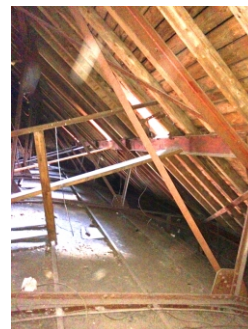
Bestandsgebäude (Dachgeschoss) vor der energetischen Sanierung
