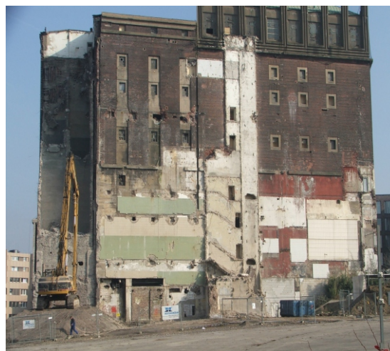
Gebäude vor der Sanierungsmaßnahme
