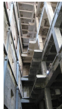
Einblick in die Deckenöffnung "Vertikale", Wandsicherungskonstruktion
