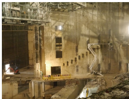
Konzertsaal - Innenabbruch der „alten“ Konstruktion
