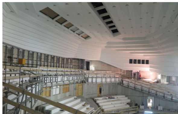
Konzertsaal - Rohbau mit Teilausbau
