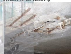
Schadensbild Stahlbetondecke
