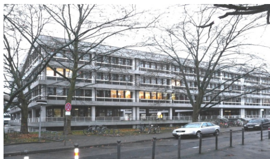
Institutsgebäude vor der Sanierung
