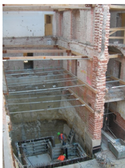
Abstützung von Mauerwerkswänden im Bauzustand (innenseitig und außenseitig)
