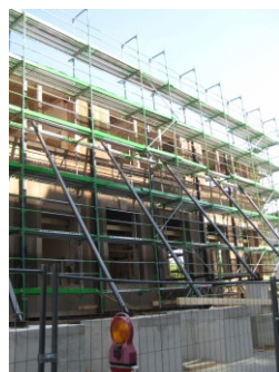
Abstützung von Mauerwerkswänden im Bauzustand (innenseitig und außenseitig)
