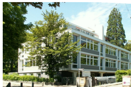
Gebäude vor der Sanierung
