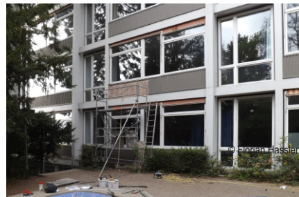
Fassade vor der Sanierung
