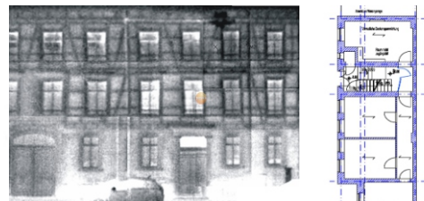
Vor Beginn der Planung: Thermographische Aufnahme zur Identifizierung der Konstruktion, Darstellung des Fachwerks
