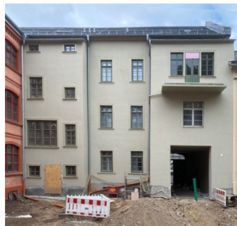
Anbau, Ansicht aus dem Innenhof
